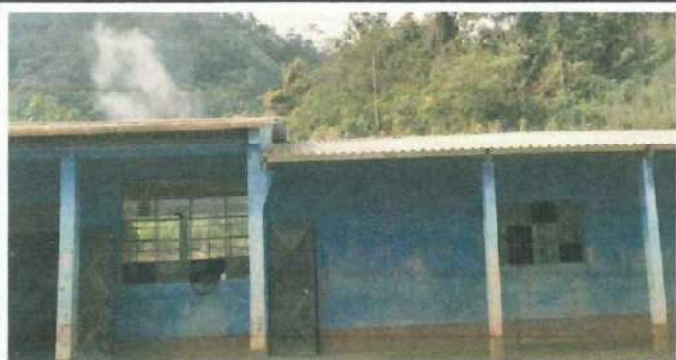
Foto 1: Sustitución de láminas troquelada a la láminas troquelada calibre 26, mantenimiento de puerta y pintura de pared interior y exterior.
