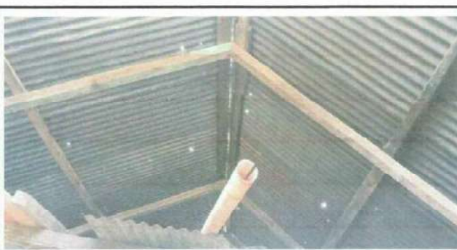
Foto 6: Sustitución portante reglas de madera a costaneras y láminas troqueladas calibre 26.
