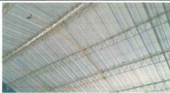
Foto Sustitución portante de láminas a costaneras.
